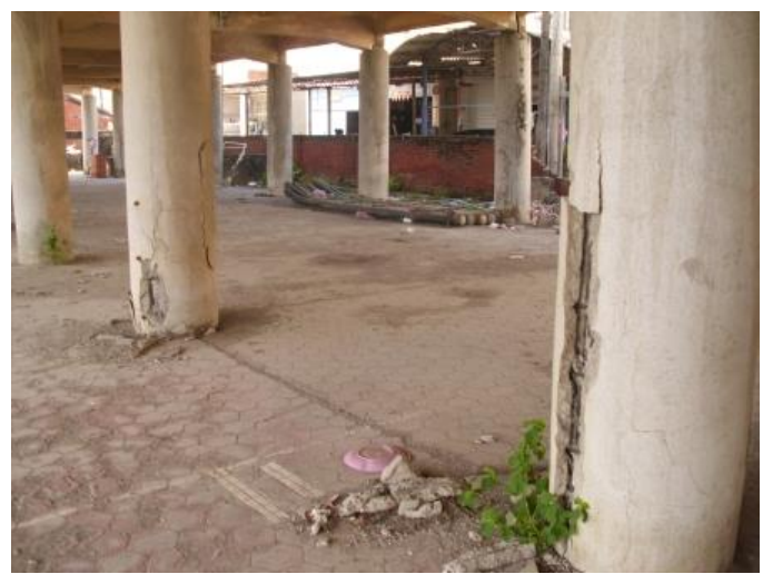
照片五、一樓基礎樑柱毀損龜裂
