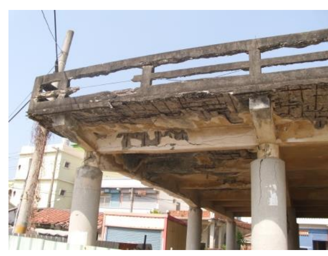
照片六、建築物外側基礎結構毀損
