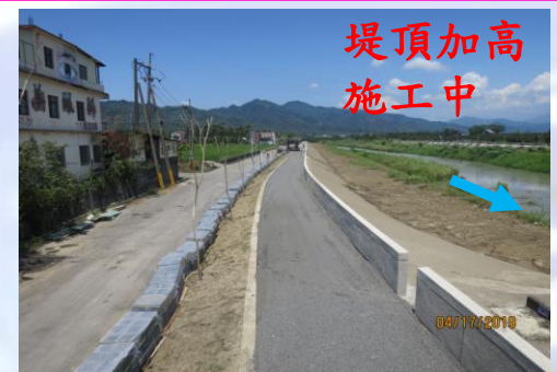
堤頂加高 施工中
