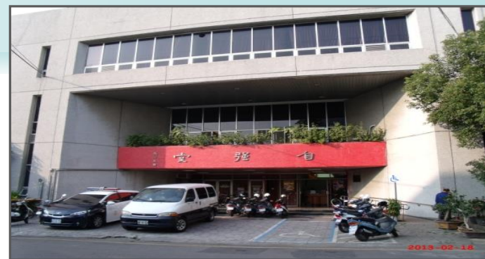
污水處理廠施工前(自強堂)
