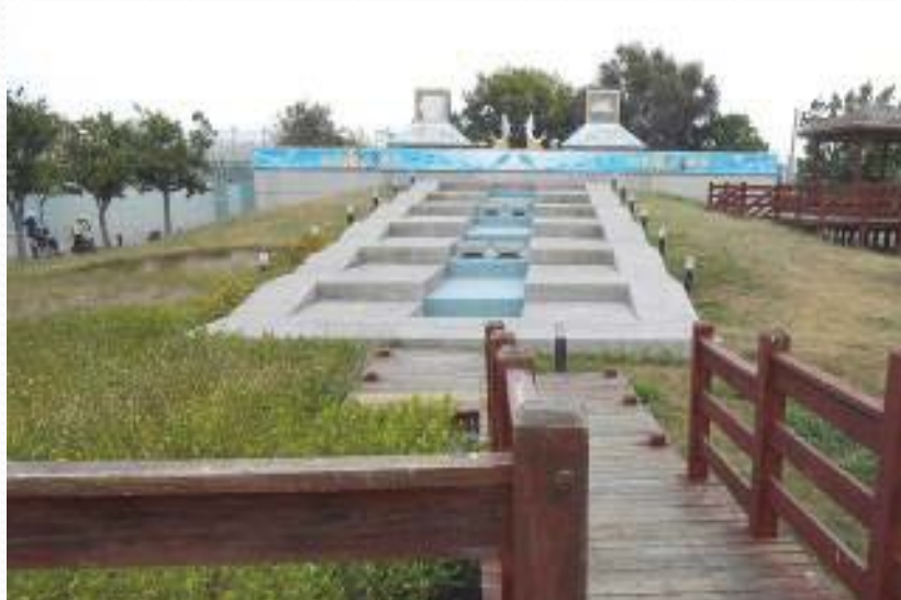
原有水道設施(已拆除)
