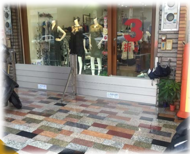
裝設水閘門防止淹入店面
