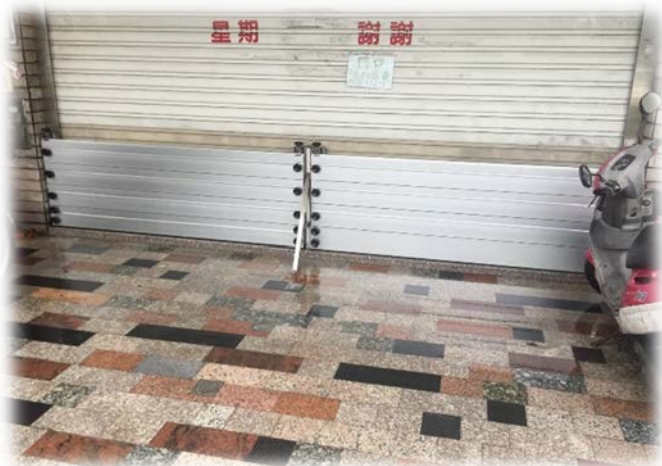
裝設水閘門防止淹入住宅
